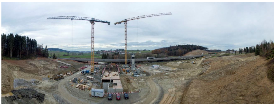
Construction installation de traitement de Grands Champs
