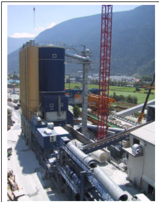
Les imposantes installations de chantier, à l'entrée du tunnel côté Rarogne (photo JDW)
