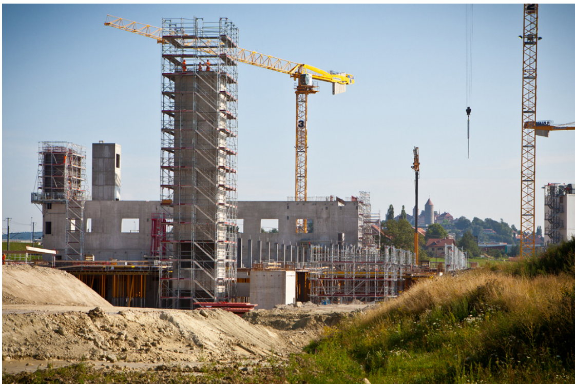
Chantier Nespresso, Romont
