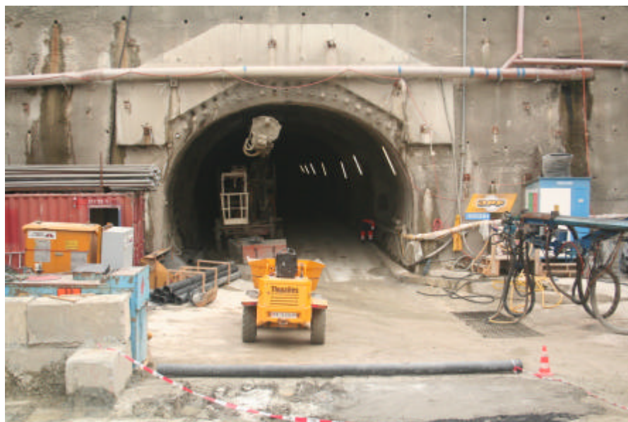
L'un des tunnels du futur métro M2 (Photo JDW)
